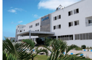
Завод в г. Рудрапур
